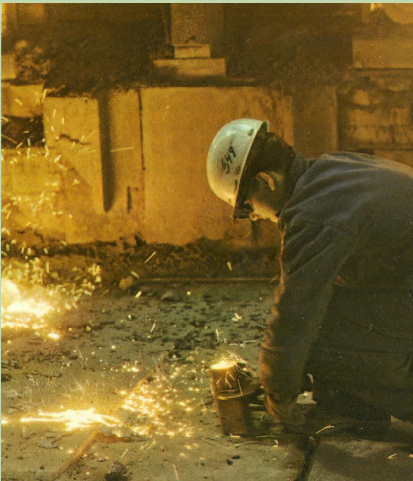
Provtagning med martinsugn i Fagersta bruk 1967, STF:s årsskrift 1967, PDM.
