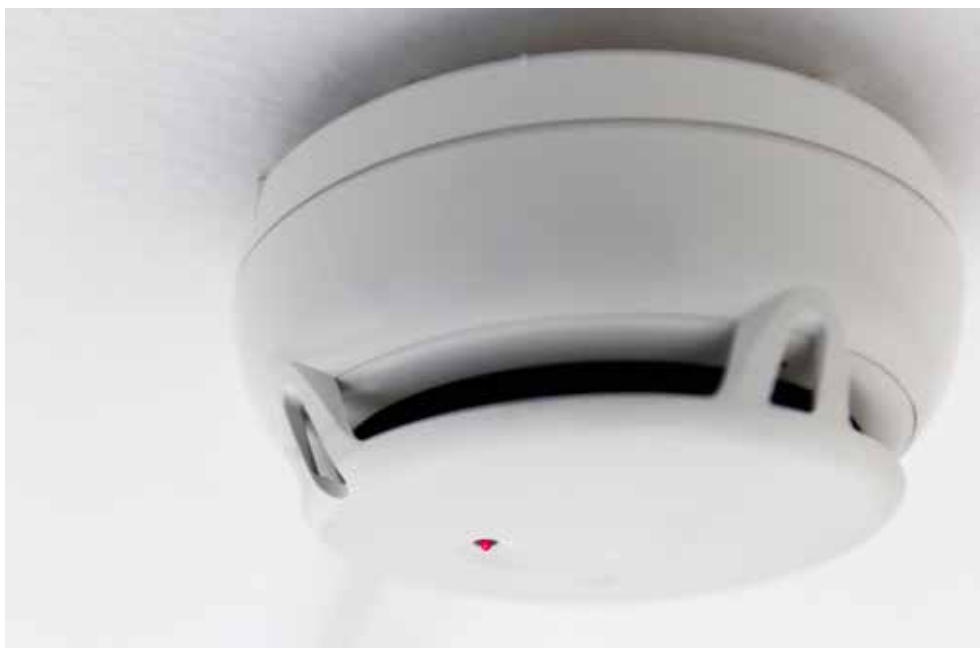
Bild 5. Optisk rökdetektor monterad i tak.
