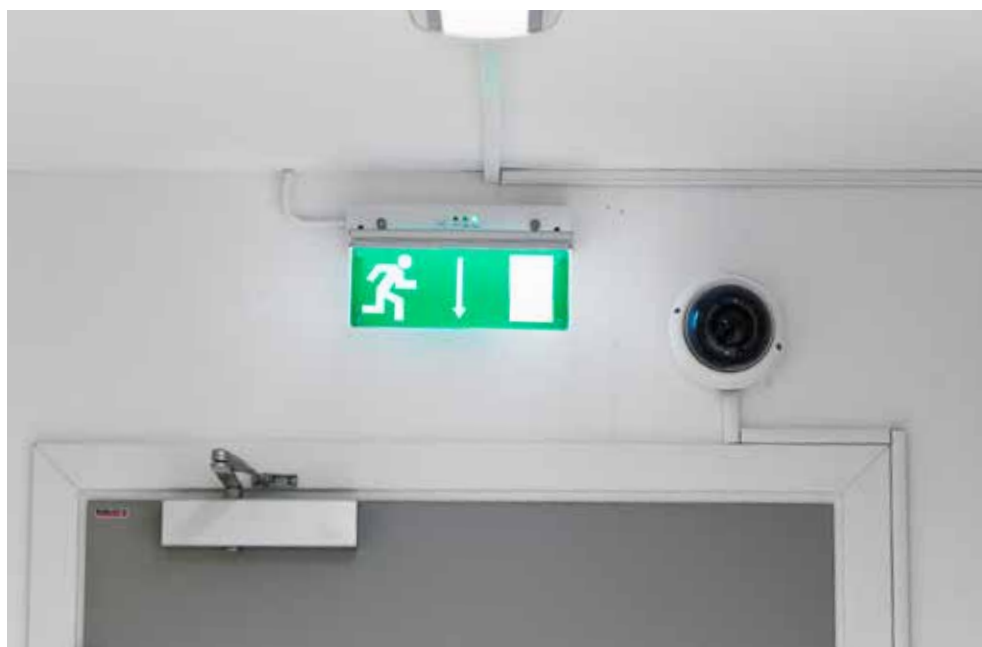
Bild 4. Kameraövervakad in- och utpassering vid ett it-utrymme
