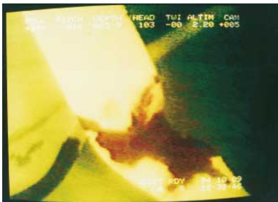
Figur 8.12 Intryckningar på en balk på rampens undersida.
