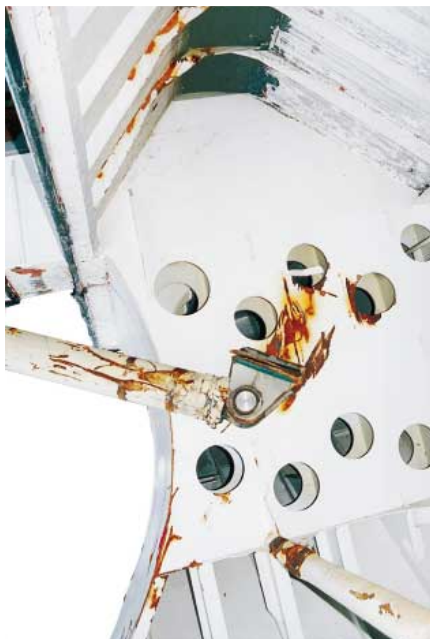
..... Figur 8.7 Slagmärken på babordssidans inre skott, den översta tvärbalken och rampens inneslutning på visirdäcket.
